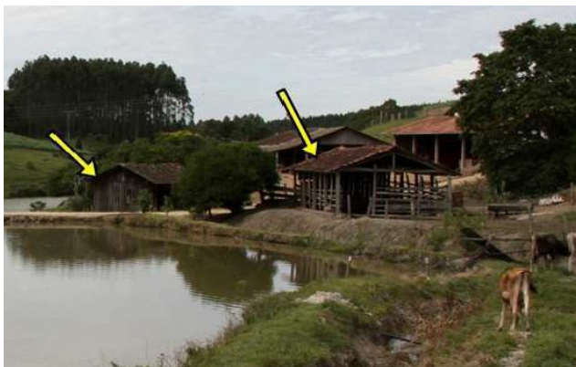
Figura 9: Estruturas a serem removidas da APP. (Fonte: Laudo Técnico nº xx/2010/CAT/CIP)
