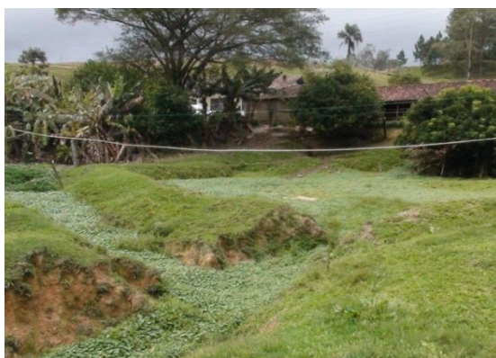
Figura 8: Tubulação que cruza a APP, a receber manutenção e possível realocação.
