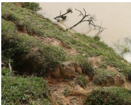
Figura 29: Processos erosivos vistos na área 3.
