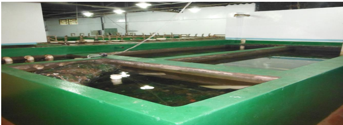
Figura 12 – Sistema de recirculação de água construído em alvenaria.
