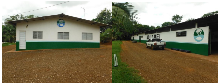
Figura 04 - Estruturas de apoio – vista externa.
