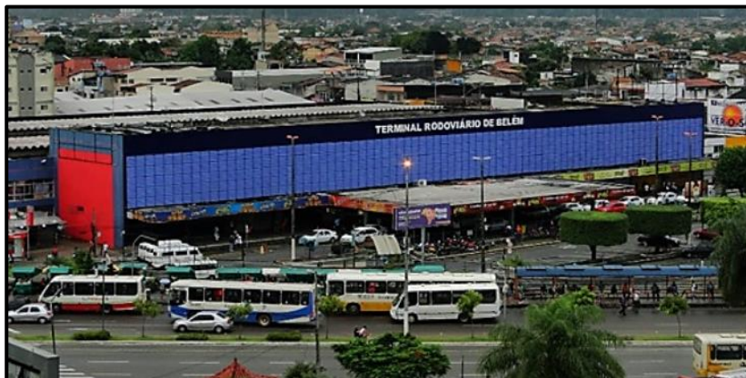
Figura 5 - Vista da frente do terminal
