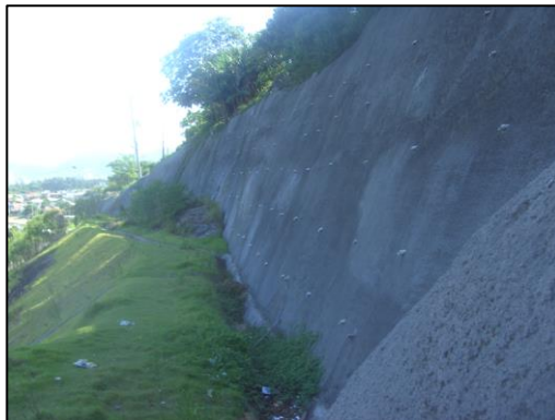
Figura 82: Parte superior de uma estrutura de contenção. Bairro São Miguel.
