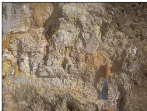
Figura 36: Granito alterado. Bairro Encruzilhada limítrofe com o bairro Saudade.
