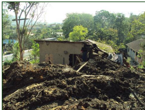
Figura 76: Casa atingida e material remobilizado na base da encosta. Bairro Prado.
