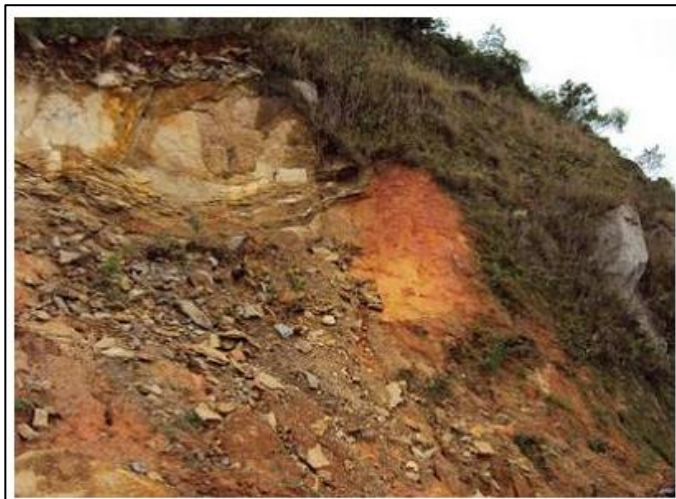
Figura 08: Detalhe de esfoliação do matacão.
