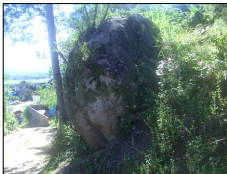
Figura 71: Matacão em situação instável. Prolongamento da Rua São Miguel, Loteamento Tiburcio. Bairro Prado.
