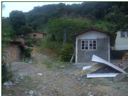
Figura 78: Ocupação na base da encosta após o deslizamento. Bairro Prado.
