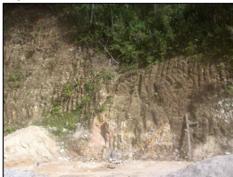
Figura 37: Vista geral do talude, local da foto anterior.
