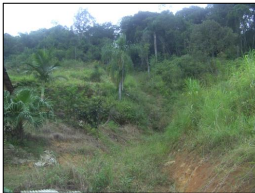
Figura 77: Local onde a massa de detrito percorreu a encosta. Bairro Prado.
