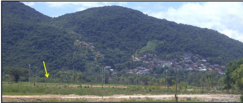
Figura 46: Ocupação urbana das encostas no bairro Prado. Em primeiro plano, loteamento situado na planície do rio Biguaçu; na sequência, modelado de morros e modelado de Montanhas. A seta indica a localização do canal fluvial do rio Biguaçu cujo perfil longitudinal contorna a base da encosta.
