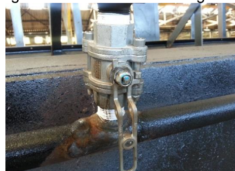
Figura 30 – Válvula de emergência
