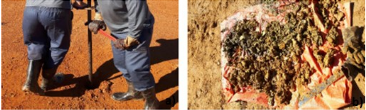
Figura 18 - a) Execução da sondagem SP-02; b) Solo retirado da sondagem SP-02
