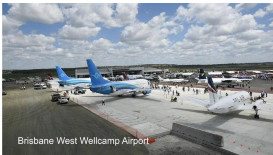
Figura 5 – Aeroporto Brisbane West Wellcamp (Austrália) foram consumidos 40 mil m 3 concreto geopolimérico no pavimento do pátio de manobras
