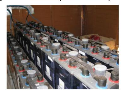
Figura 20 – Banco de baterias tipo OPzV instalados em prateleiras
