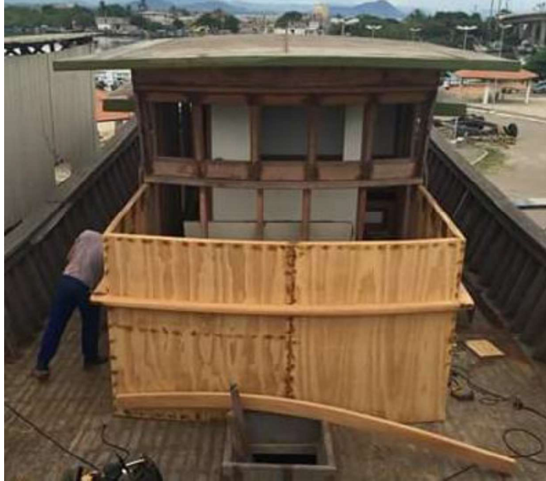
Figura 1 – Casaria sendo construída utilizando compensado
