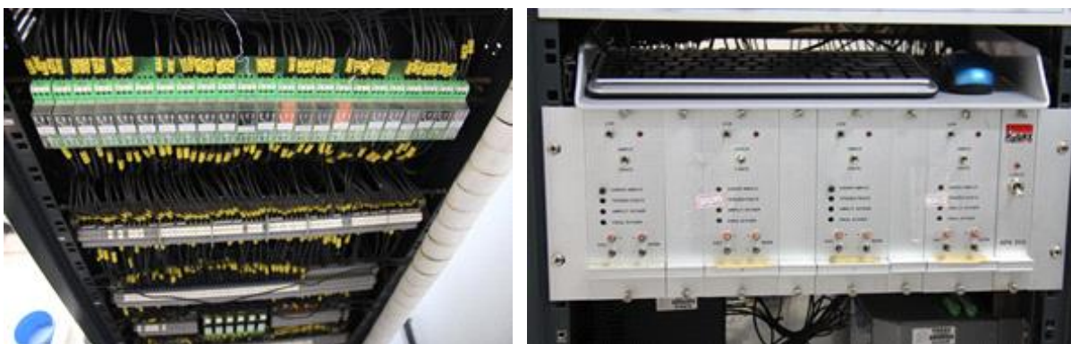
Figura 13 – Vista da parte de trás do RAM mostrando as conexões elétricas e relés (E) e amplificador Reivax APX200 (D) no painel frontal.
