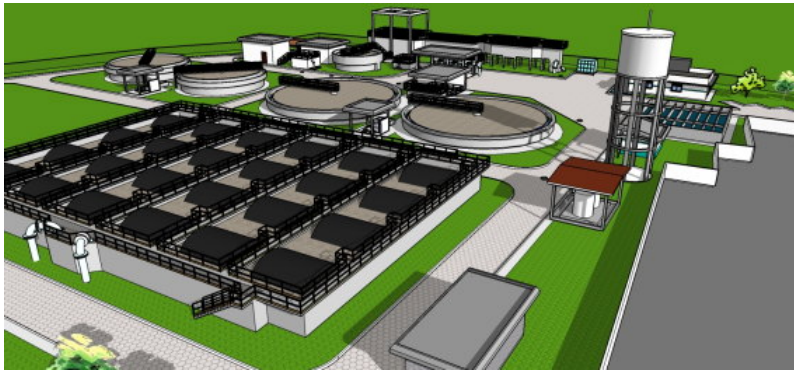
Figura 4 – Estação de tratamento de esgoto lodo ativado.
