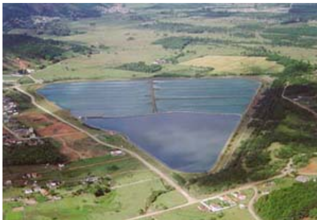
Figura 5 – Sistemas de potecas (fonte: CASAN).
