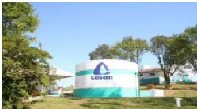
Figura 9 – ETA Meleiro (fonte: CASAN)
