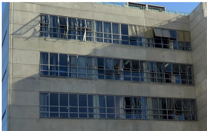
Figura 31 - Fachada com grande área de janelas
