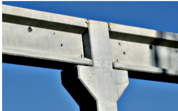
Figura 25 - Viga I apoiada sobre consolo trapezoidal
