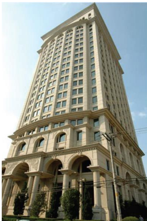
Figura 12 - Fachada com elementos e painéis pré-moldados
