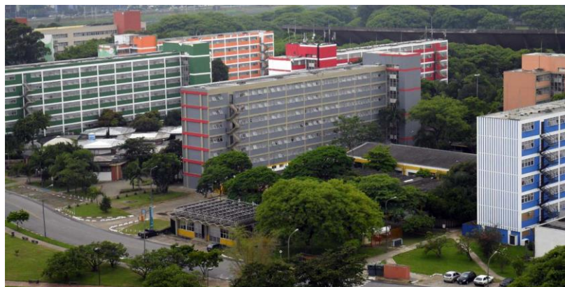
Figura 3 - Edifícios do CURSP (Conjunto Residencial da Universidade de São Paulo)
