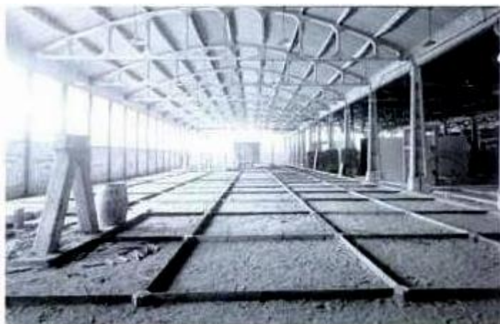
Figura 2 - Pavilhão do Cortume Franco-Brasileiro, em fase inicial de construção
