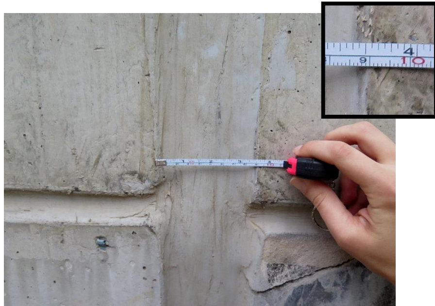
Figura 44 - Junta vertical com 9 cm de espessura
