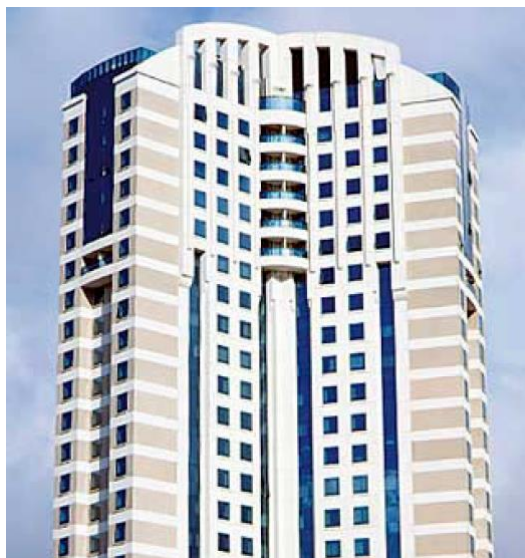
Figura 4 - Edifício Blue Tree Towers com painéis pré-fabricados de concreto
