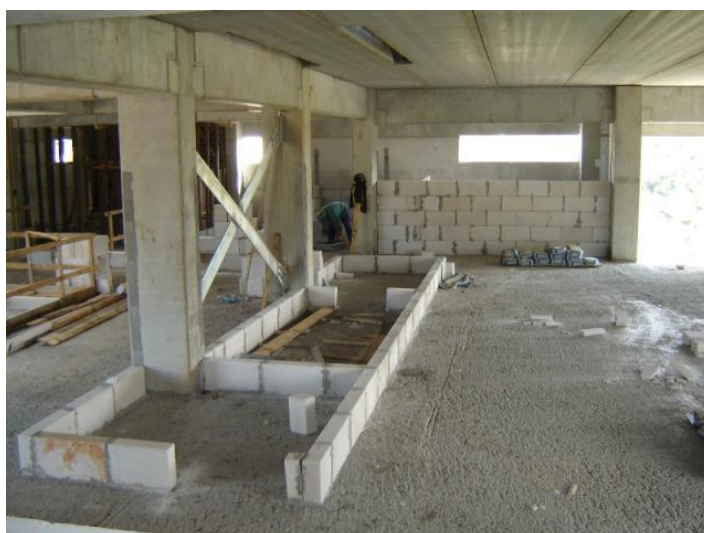
Figura 40 - Execução da alvenaria
