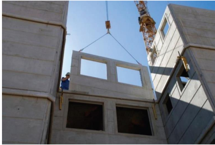
Figura 9 - Construção com painéis com aberturas para esquadrias
