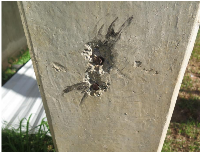
Figura 60 - Alça de içamento cortada
