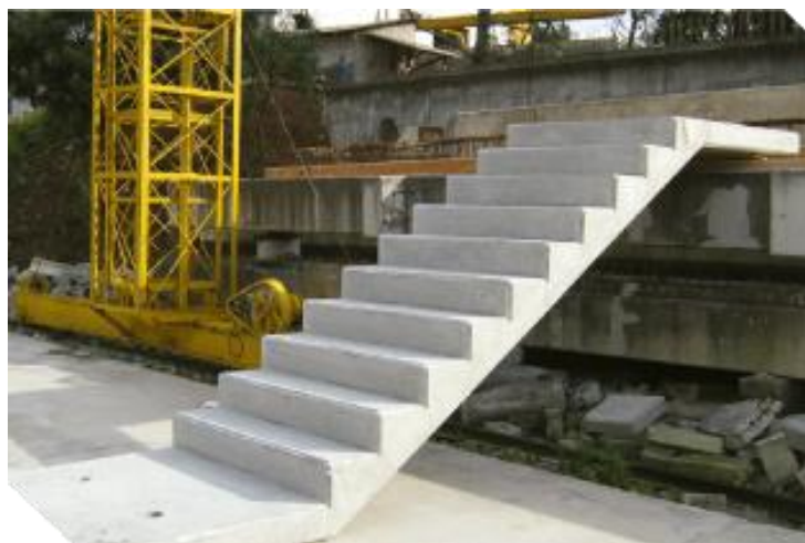
Figura 18 - Exemplo de escada pré-moldada reta
