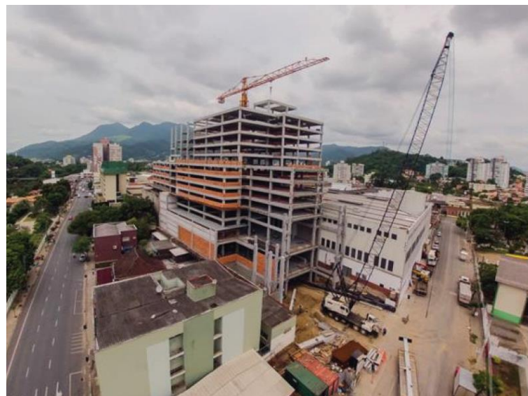
Figura 7 - Exemplo de estrutura pré-moldada em esqueleto
