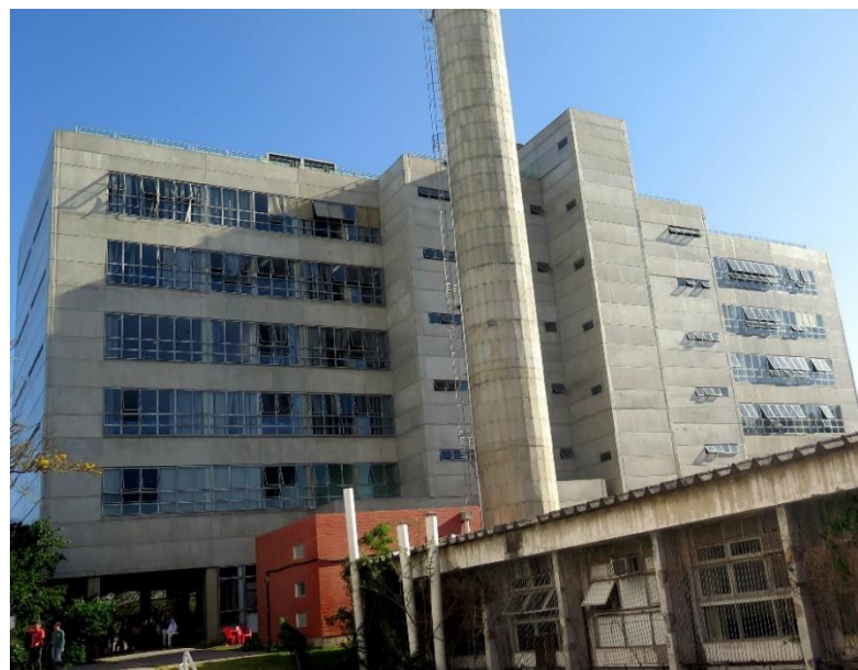
Figura 38 - O prédio EFI
