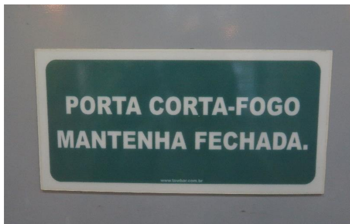
Figura 66 - Letreiro da porta corta-fogo
