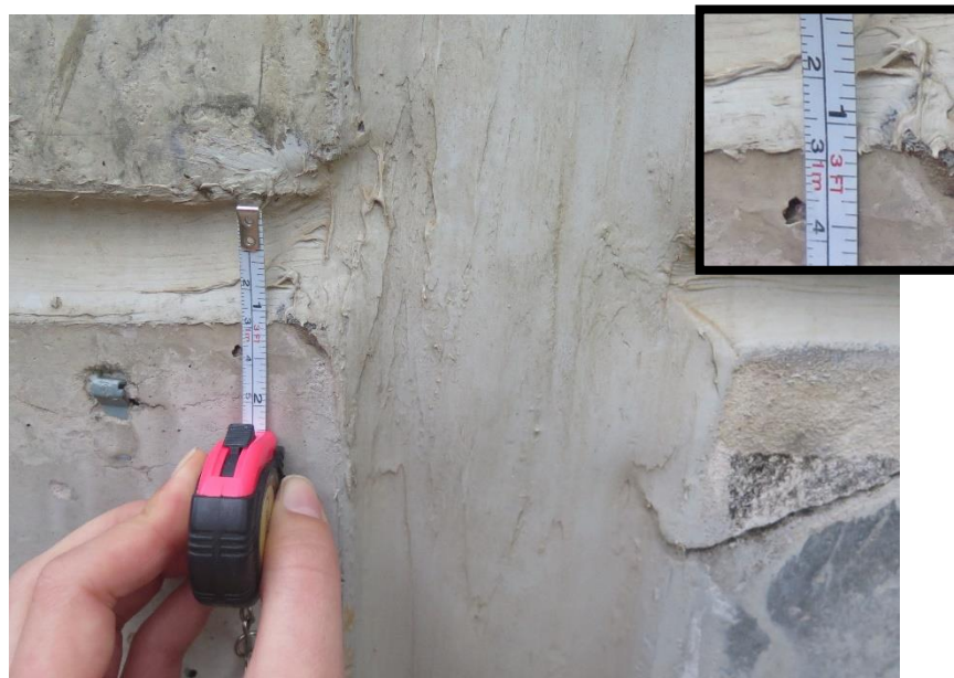
Figura 45 - Junta horizontal com 3 cm de espessura
