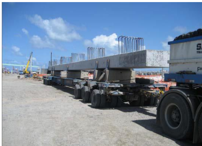
Figura 35 - Transporte de pilar com 35 metros de altura
