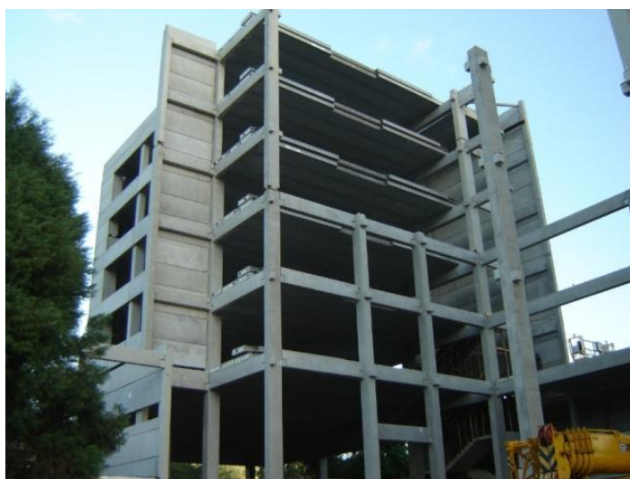
Figura 39 - Montagem da estrutura
