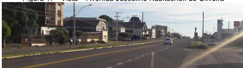
Figura 17 - Vista – Avenida Juscelino Kubitschek de Oliveira
