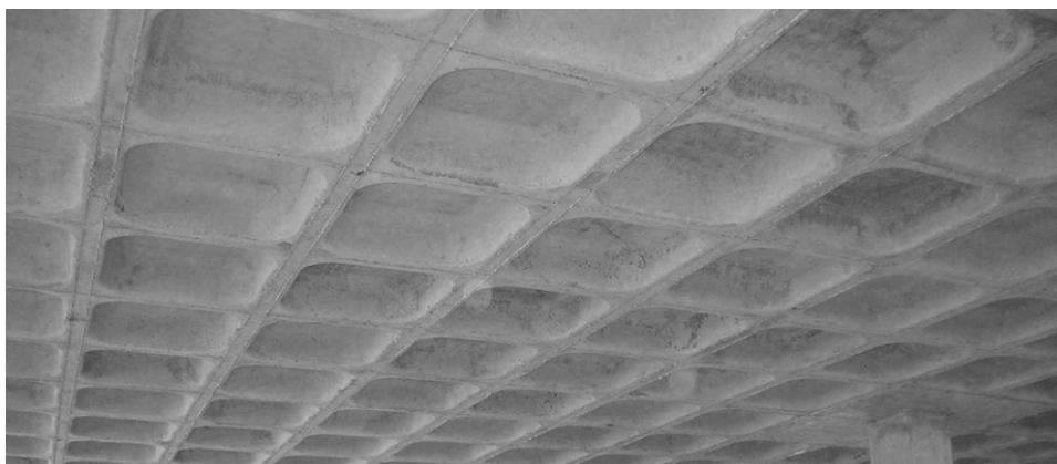
Figura 10 - Acabamento da laje nervurada com a utilização de fôrmas reaproveitáveis
