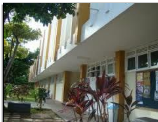
Escola de Engenharia da UFRN [Outro prédio onde funcionou o Instituto de Matemática]
