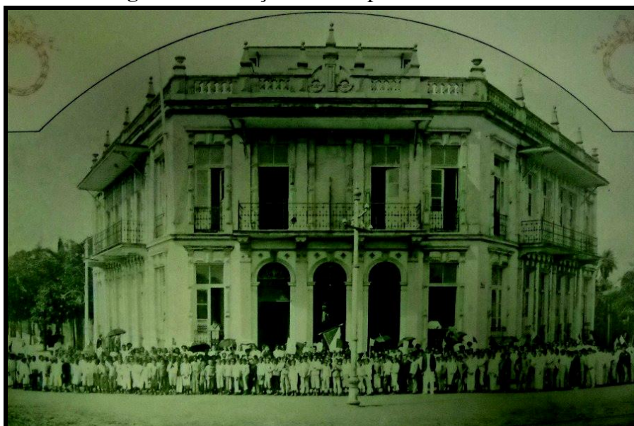
Imagem 1: Instalações do Grupo Escola Dr. Freitas
