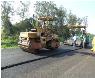
b) Compactação com rolo compactador liso
