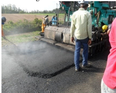
a) Aplicação da mistura pela vibro acabadora
