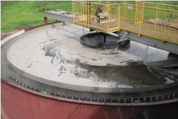
Figura 3.4 – Clarificador de água por sedimentação das partículas
