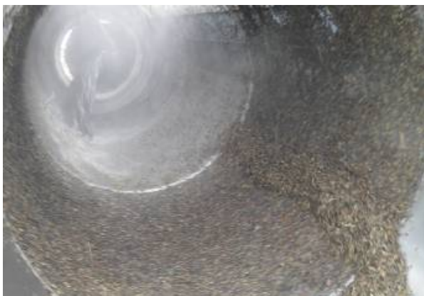
Figura 3.3 – Peneira rotativa para retirar da água de lavagem o material grosseiro
