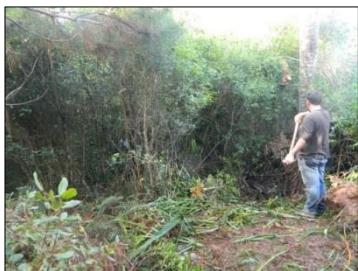
Figura 60 - Supressão da vegetação na área de demarcação da Trincheira A.
