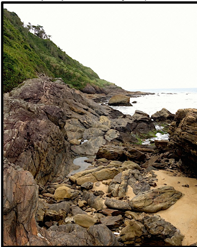
Figura 64 – Queda de detritos com a formação de depósitos clásticos (tálus) retrabalhados pela ação marinha.
