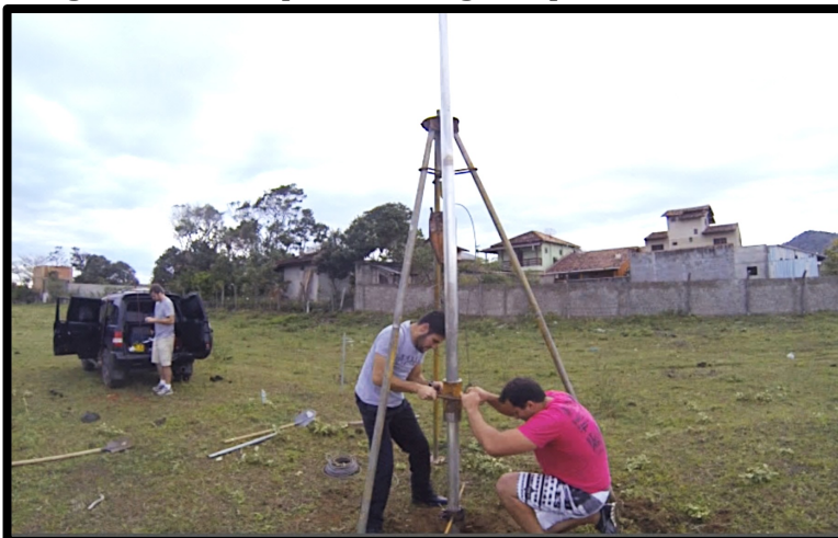
Figura 34 – Exemplo de sondagem à percussão manual.
