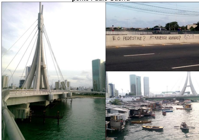
Figura 42 – Ponte estaiada – acesso da Via Mangue a partir da ponte Paulo Guerra
