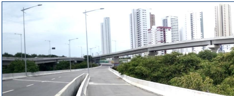
Figura 23 – Via Mangue – Elevados de acesso sobre a Rua Antônio Falcão
