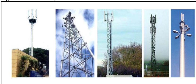
Figura 9: Diferentes tipos de torres com antenas instaladas.
