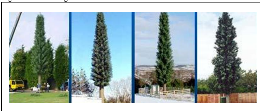
Figura 10: Camuflagem de torres e antenas.
