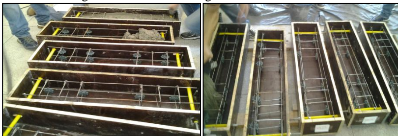
Figura 4.1: Fôrmas das vigas de concreto armado.
