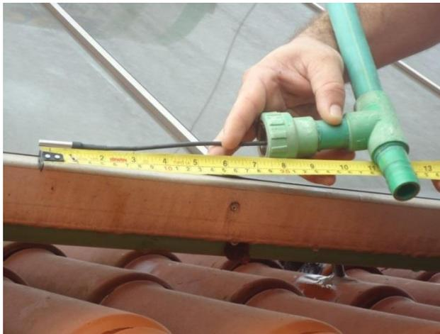
A Figura 55 demonstra o sensor sendo colocado no interior do reservatório.
