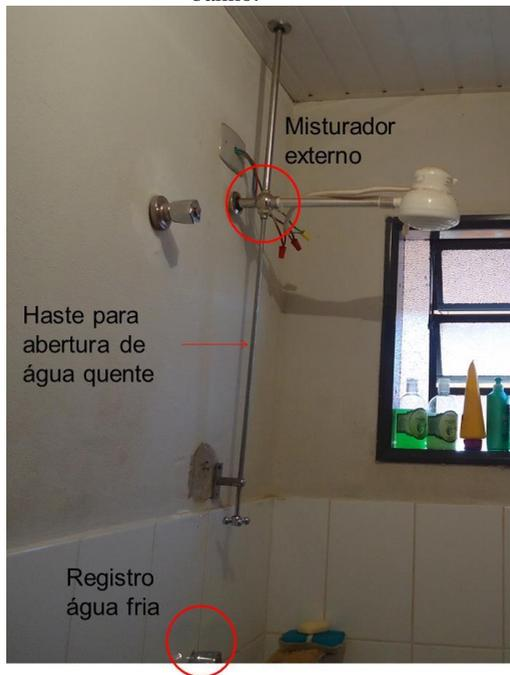
Assim como os demais sistemas de aquecimento solar subsidiados pelo governo federal, o presente não possui resistência elétrica no interior do reservatório térmico. O sistema auxiliar de aquecimento é o chuveiro elétrico. As unidades receberam um chuveiro elétrico com potência nominal de 4500 W, com três níveis de temperatura, sendo frio, morno e quente. Com a posição da chave ao centro (frio), a resistência elétrica permanece desligada. Com a chave na
