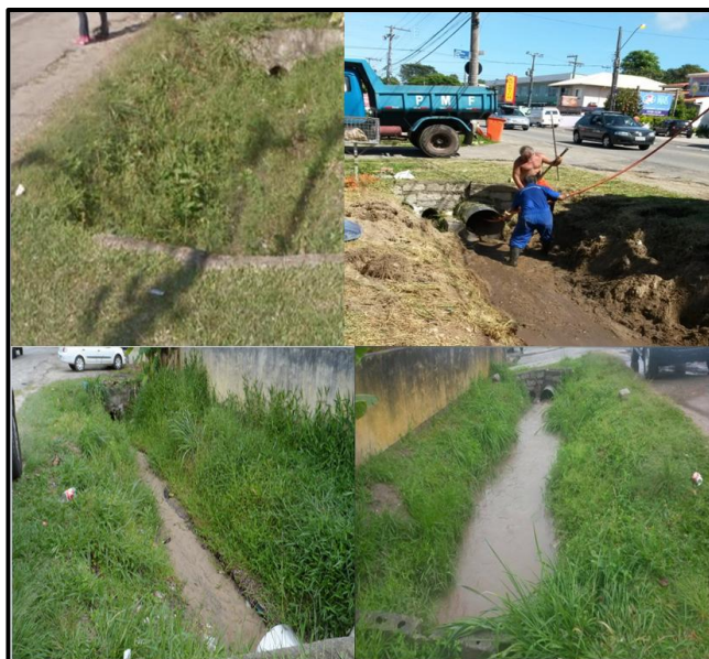
Figura 10-Vala de infiltração
