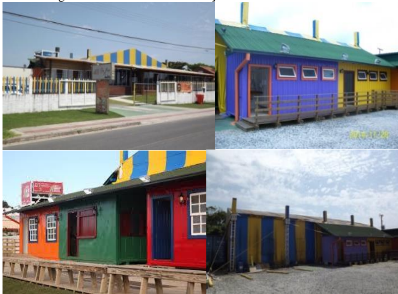
Figura 48 – Detalhes da construção do Circo da Dona Bilica
