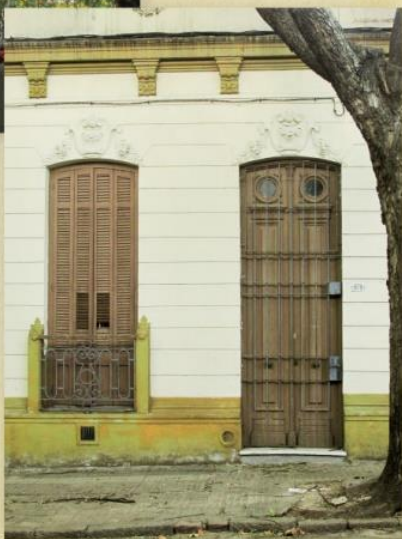
35 – Vista da Casa Félix. Calle Defensa 1678.
