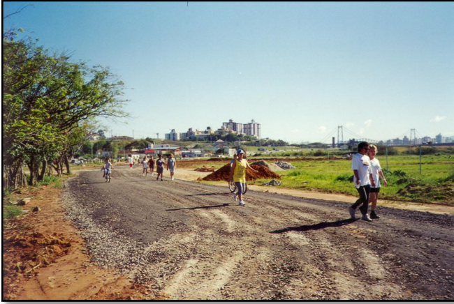
Figura 10: Utilização das pistas do Parque de Coqueiros ainda em construção Fonte: SCHAEFER, [201?], p. 9.
