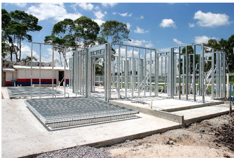
Figura 30: Montagem de perfis steel frame. Fonte: LP Building Products 2012
