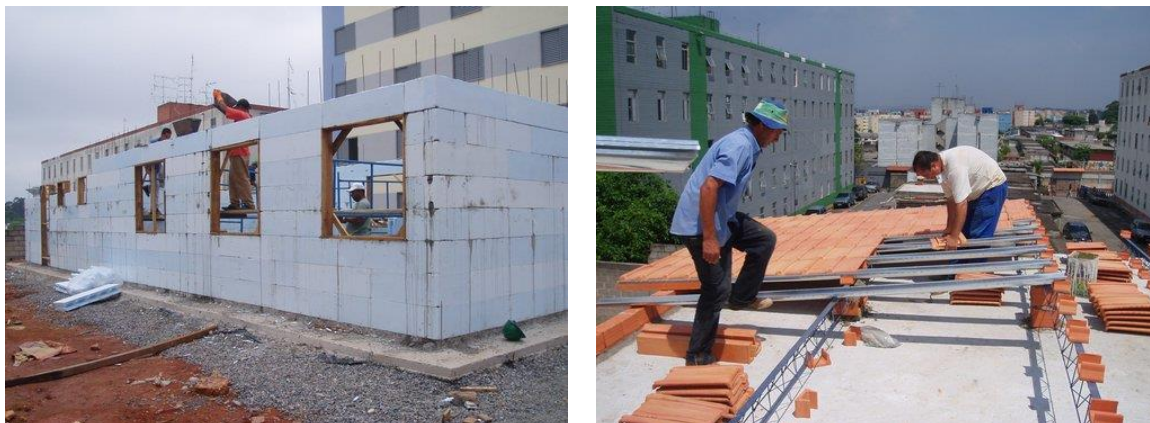
Figuras 16: Execução das paredes e cobertura do sistemas ISOCRET. Fonte: ISOCRET (2010). 22
