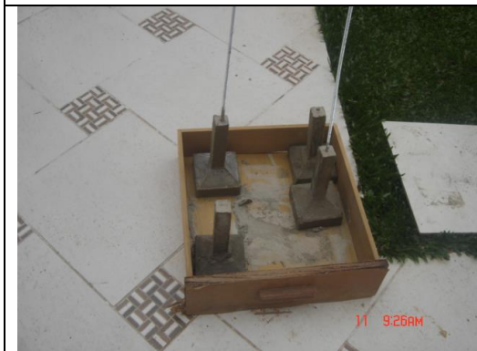
Confecção das fundações – sapatas em concreto armado – etapa de desforma.
