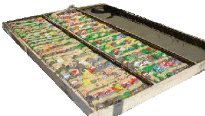
Figura 33: Disposição de garrafas plásticas para confecção de painel.
