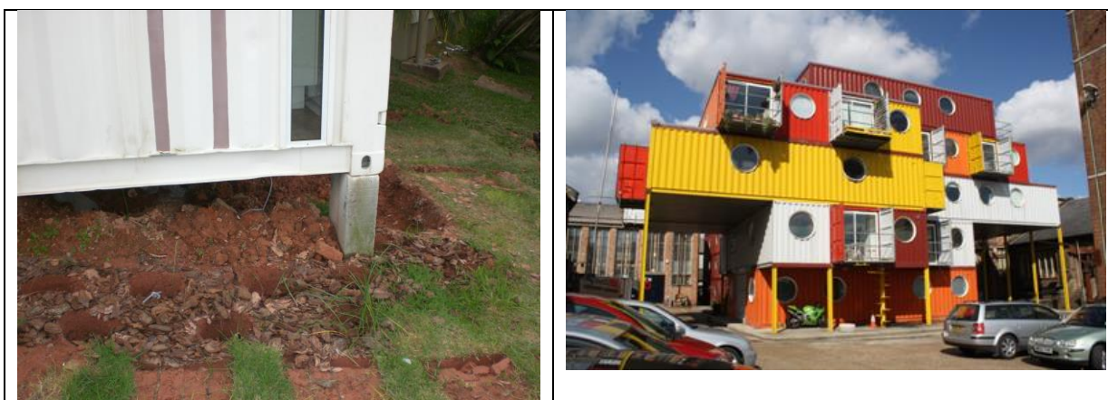
Figura 26: Assentamento do contêiner sobre fundação e edifício contêiner. Fonte: FRASSETO (2011). 29
