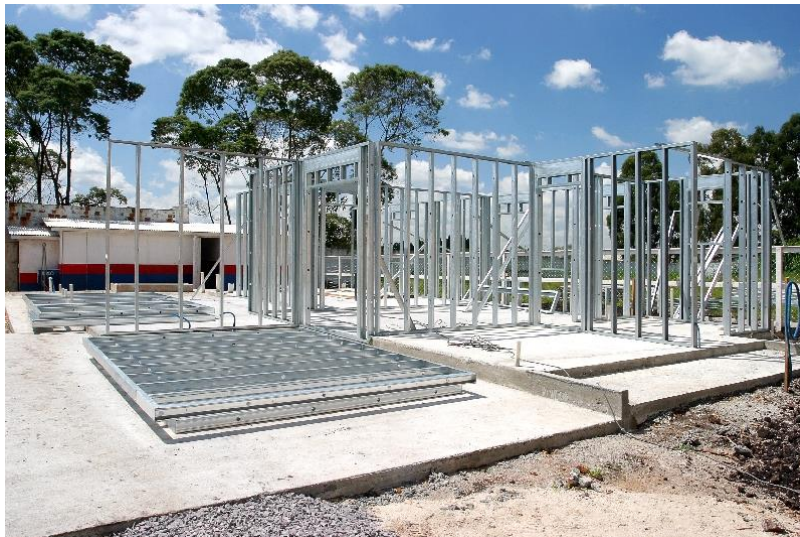
Figura 1: Montagem de perfis steel frame. Fonte: LP Building Products 2012
