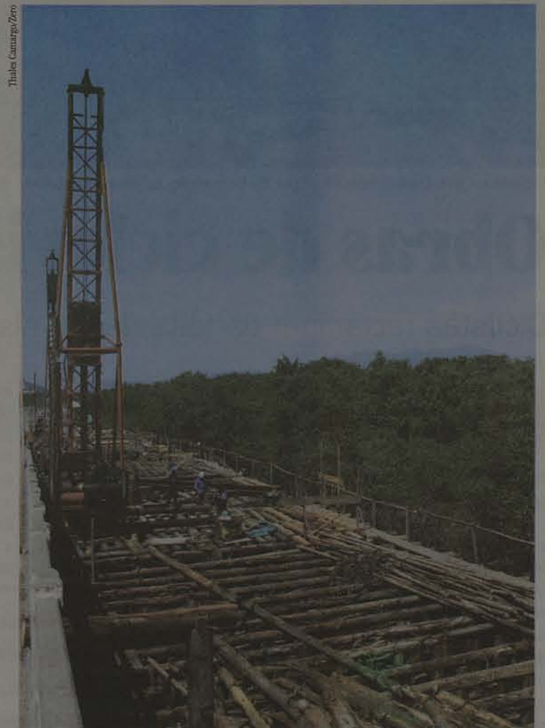
Os trabalhos na nova ponte sobre o Rio Tavares estão dentro do prazo
