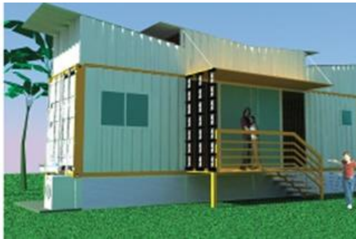
Figura 13: Habitação em container.
