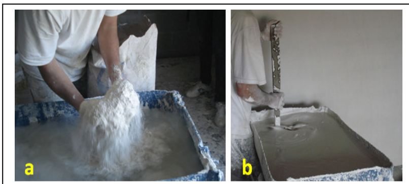
Figura 13 - Polvilhamento e mistura do gesso para revestimento Fonte: Acervo pessoal – Obra Município de Palhoça.
