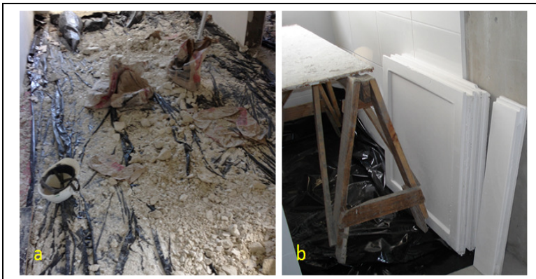
Figura 22 - Forração do piso para recolhimento do gesso
