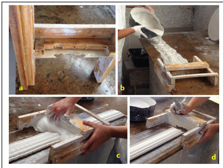
Figura 44 - Fabricação de peças de acabamento de forro de gesso
