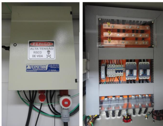
Figura 4.32 – Painel de proteção elétrica – LASER e chiller (Autor)
