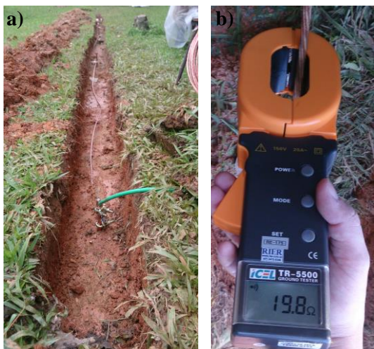
Figura 4.33 – Aterramento do sistema LASER (Autor)
