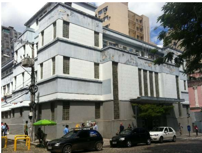
FIGURA 40 - Vista. Externa da Agência dos Correios.
