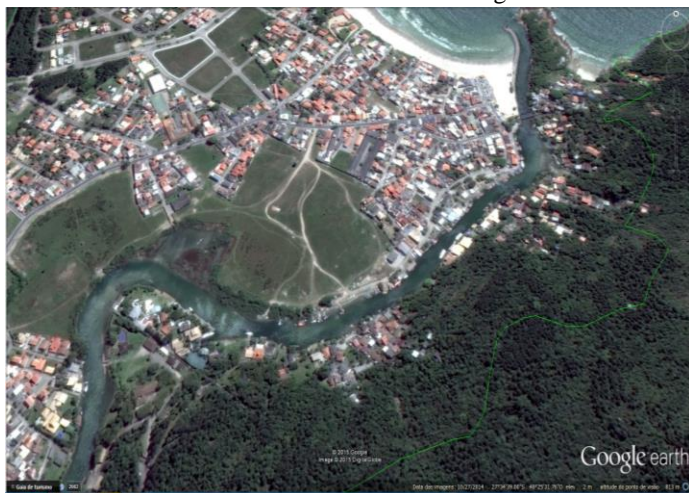
Figura 9 - Molhe na entrada do Canal da Barra da Lagoa.
