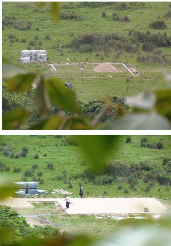
Figura 34 - Heliporto sendo construído e pronto para pouso e decolagem.
