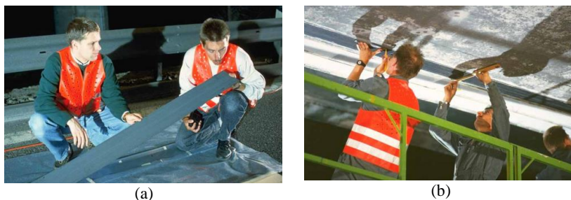
Figura 1.2 – (a) Lâminas de PRFC, (b) Execução do reforço: colagem das lâminas ao concreto.
