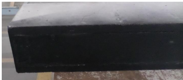
Figura 6.24 – Imagem fotográfica da viga LCR, lado esquerdo, na qual não se visualiza a delaminação a olho nu.
