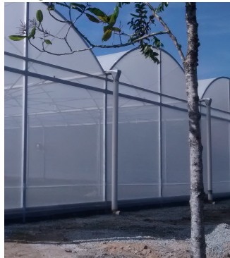
Figura 1 – Abrigo de cultivo com estrutura em aço.
