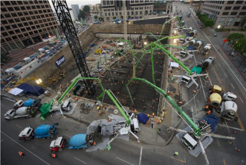
Figura 1- Concretagem do bloco de fundação do edifício New Wilshire Grand em Los Angeles/EUA no ano de 2014
