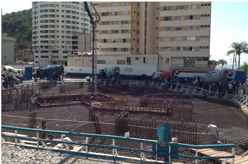
Figura 2 - Concretagem do bloco de coroamento do empreendimento Infinity Coast em Balneário Camboriú/SC no ano de 2014
