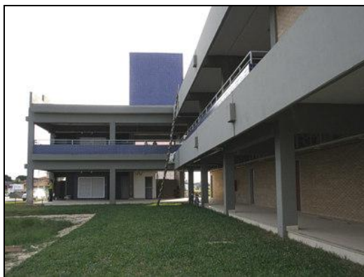
Figura 18: Vista interna do Prédio
