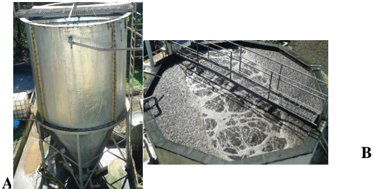
Figura 7- Reator anaeróbio UASB (A) e Reator biológico de lodos ativados RBLA (B). Fontes de biogás e meio de nutrientes, respectivamente.
