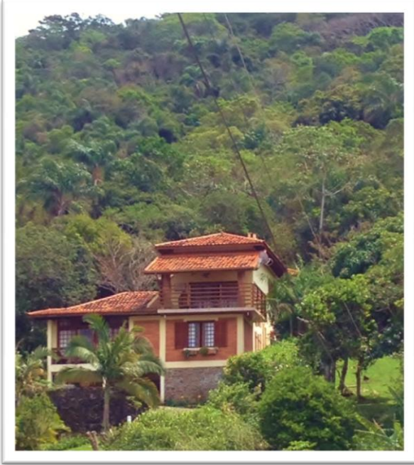
Figura 04: Estrutura Atual Fonte: arquivo pessoal
