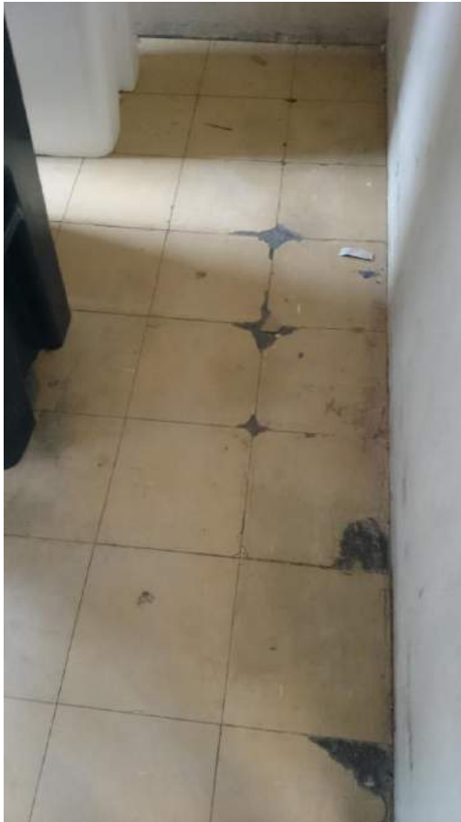
Figura 31 - Detalhe do mau estado de conservação do piso do armazenamento temporário
