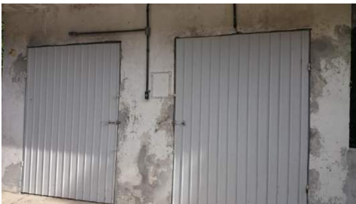
Figura 15 - Visão externa do abrigo de resíduos químicos (à esquerda) e infectantes (à direita)
