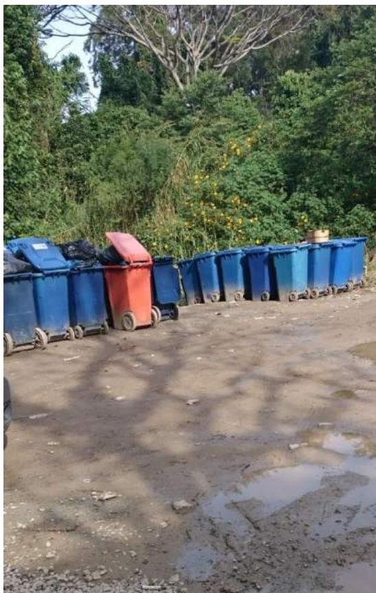
Figura 34 - Armazenamento externo dos resíduos comuns
