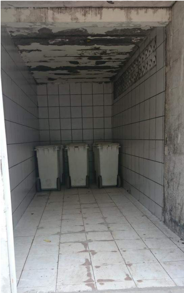
Figura 17 - Interior do abrigo de resíduos infectantes
