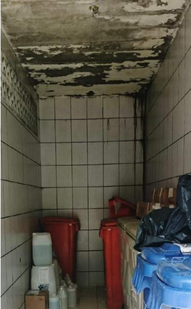
Figura 35 - Situação do abrigo de resíduos químicos
