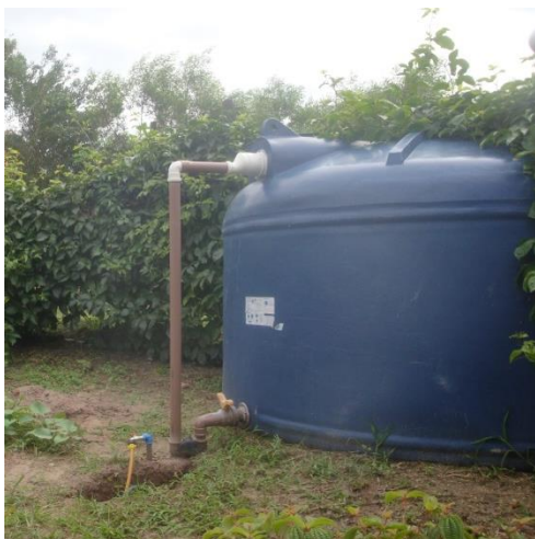
Figura 7 - Cisterna que armazena a água coletada
