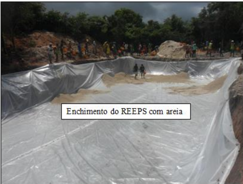
Figura 3 - Início da construção de um REEPS
