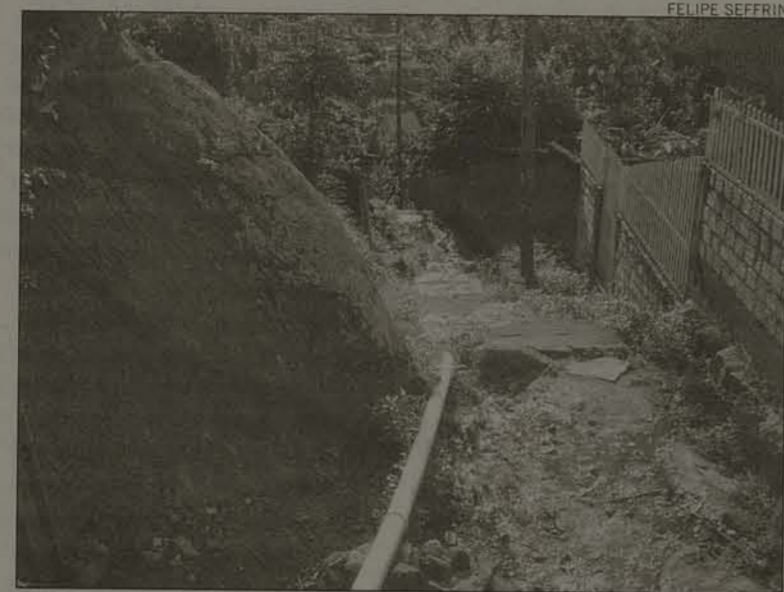
TICO-TICO No morro, esgoto divide espaço com casas e escadarias
