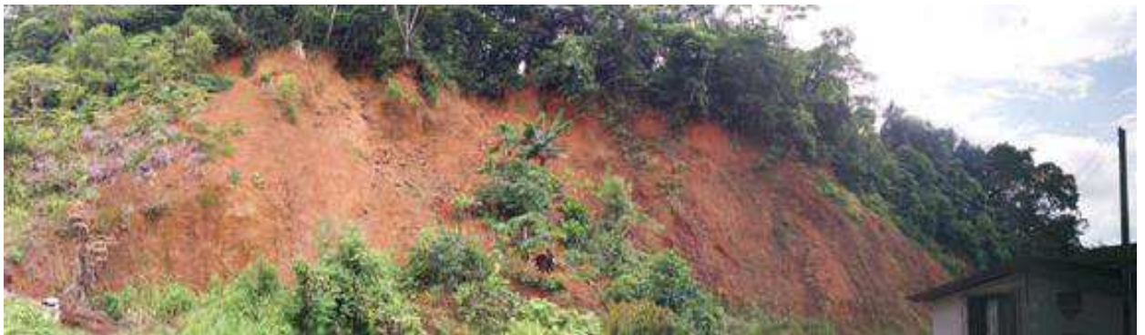
Figura 52 - Visão panorâmica da encosta localizada no bairro Iririú
