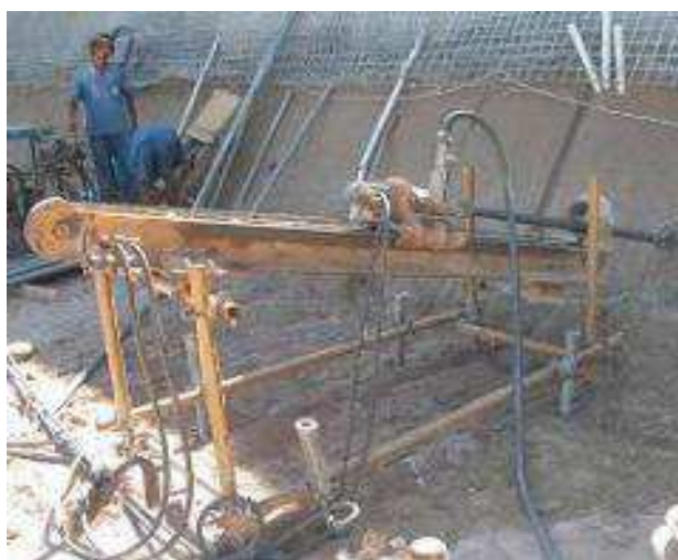
Figura 23 – Equipamento mecanizado para abertura de orifício para inserção de grampos
