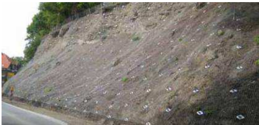
Figura 27 - Cobertura de superfície utilizando telas metálicas
