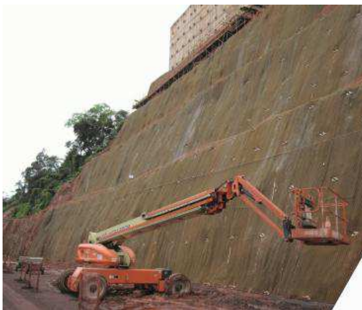
Figura 49 - Projeto executado para estabilização de talude com inclinação próxima a 90°
