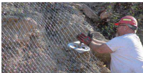
Figura 35 - Instalação de placa de ancoragem sobre a face da encosta e peça em detalhe, respectivamente
