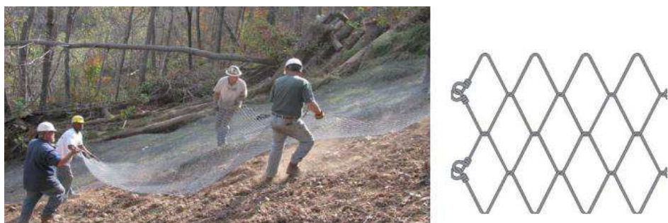
Figura 33 - Preparo para instalação, assim como configuração geométrica das telas de alta resistência
