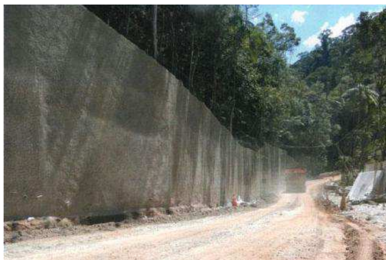
Figura 37 - Contenção com solo grampeado e faceamento em concreto projetado apresentando 90^\circ de inclinação
