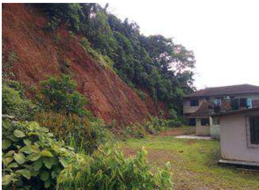
Figura 50 - Encosta de alta inclinação localizada próxima a construções residenciais
