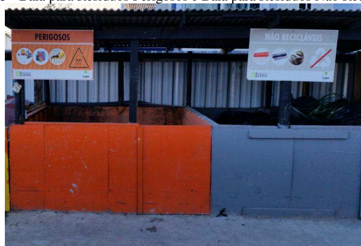
Figura 25 - Baia para Resíduos Perigosos e Baia para Resíduos Não Recicláveis
