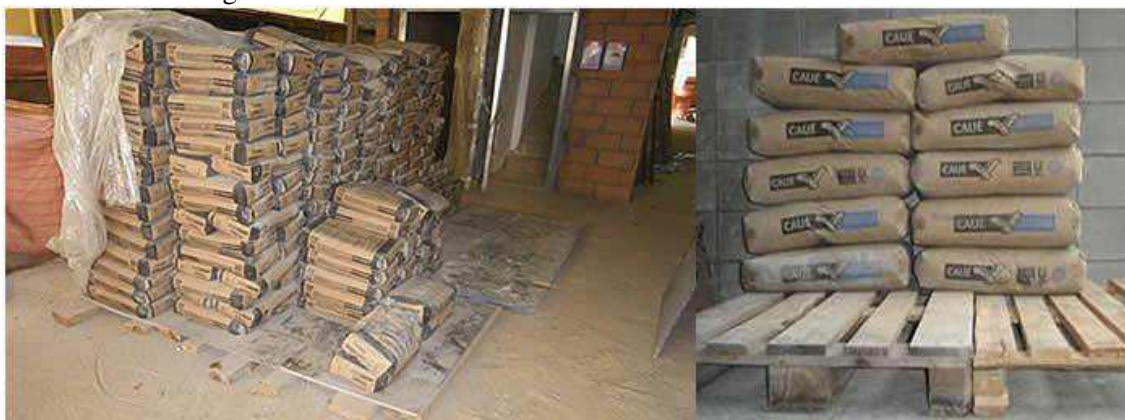
Figura 10 - Armazenamento de Materiais no Canteiro de Obras
