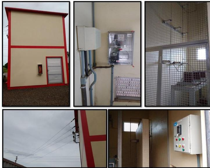
Figura 10 – Subestação da Empresa Beneficiadora de Arroz. (Fonte: Autor, 2016)
