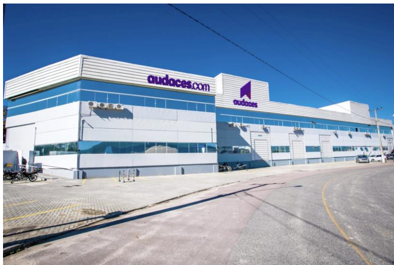
Figura 135: Aplicação Fachada. Fonte: da autora (2016).
