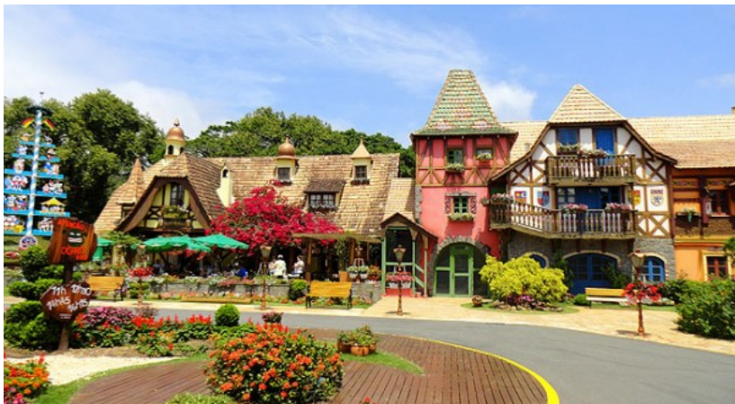
Figura 24: Técnica construtiva enxaimel em Blumenau, Santa Catarina.
