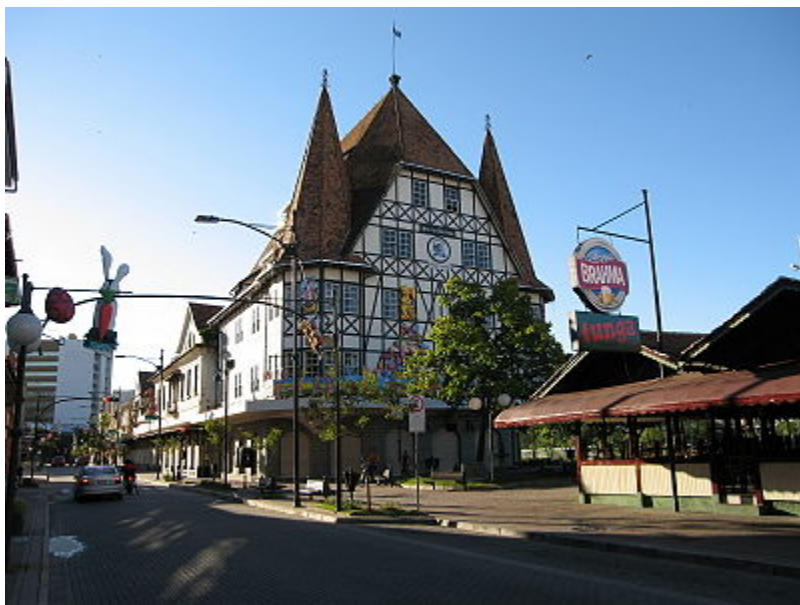
Figura 23: Técnica construtiva enxaimel em Blumenau, Santa Catarina.
