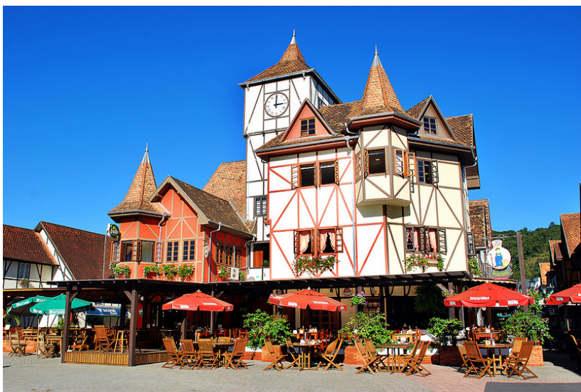
Figura 25: Técnica construtiva enxaimel em Blumenau, Santa Catarina.
