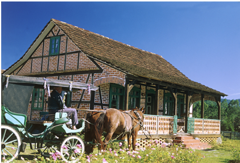
Figura 26: Técnica construtiva enxaimel e charrete típica germânica em Pomerode, Santa Catarina.
