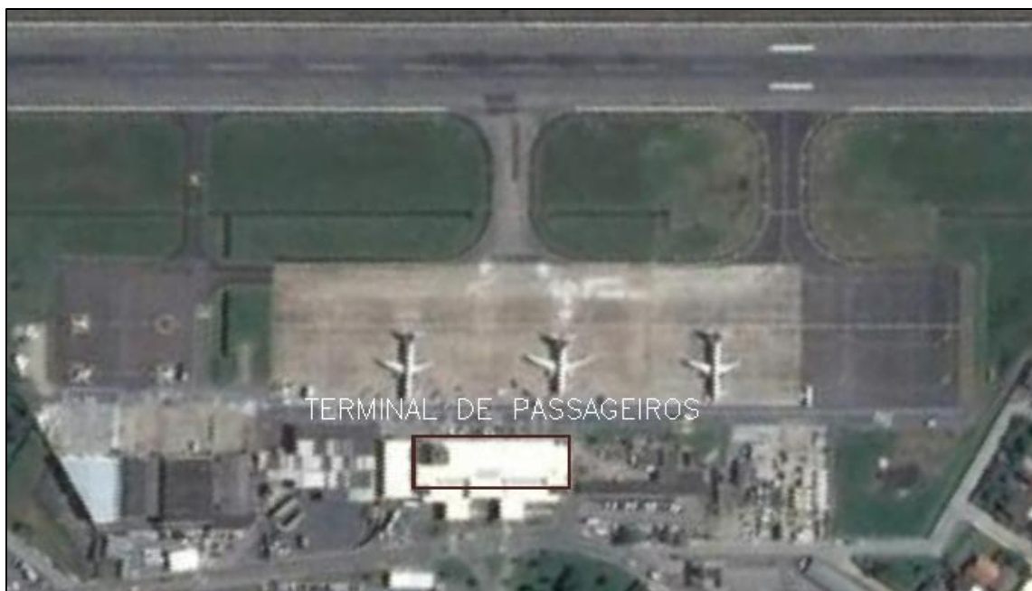
Figura 9 - Terminal de passageiros
